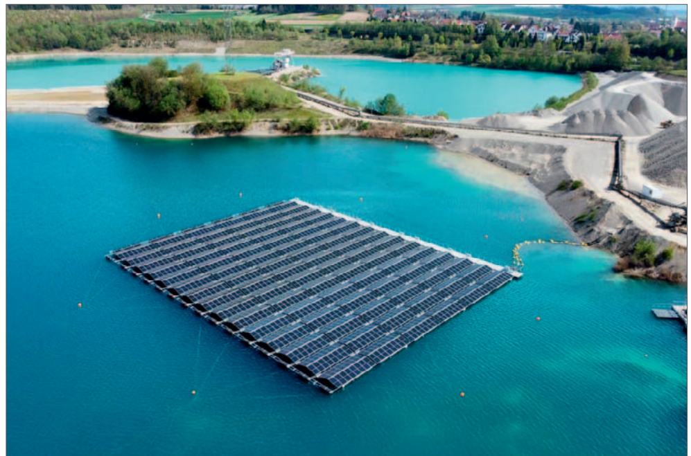
Schwimmende PV-Anlage der Fa. Kies- und Schotterwerke Müller GmbH & Co. KG, Ostrach/Württemberg
