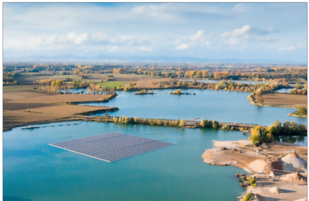
Floating PV-Anlage der Erdgas Südwest GmbH in Leimersheim
