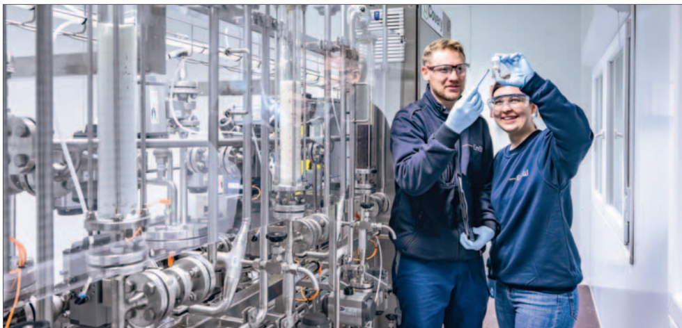
Prototyp einer Lithiumgewinnungsanlage am Standort Bruchsal
