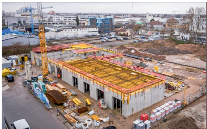
Das Technikgebäude für die iKWK-Anlage entsteht (Stand: Anfang Februar 2022)
