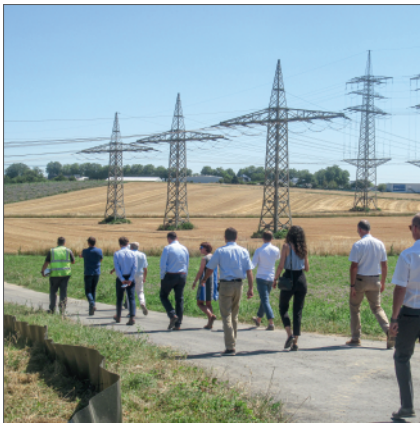
Kurze Besichtigungsrunde am Gelände des Umspannwerks Leingarten/Großgartach, das als Standort für den Konverter vorbereitet wird
