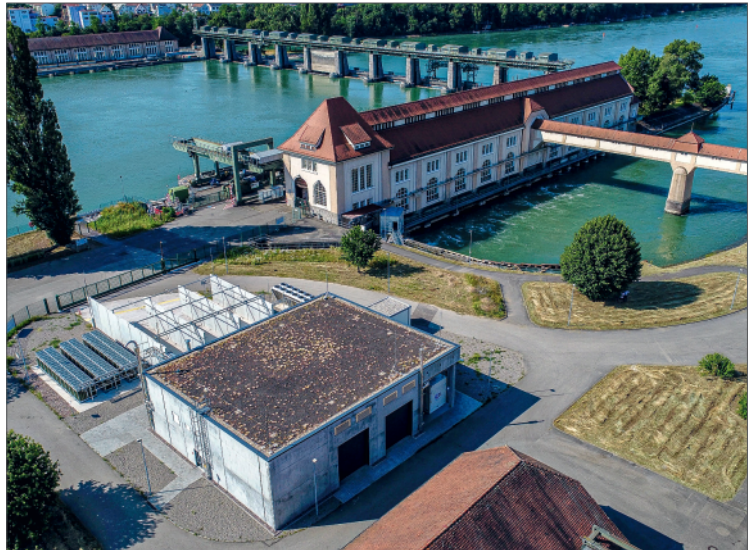
Power-to-Gas-Anlage (vorne) und Wasserkraftwerk Wyhlen
