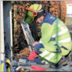
Betriebsmonteur der Stuttgart Netze beim Einbau der SMIGHT-Sensoren in Kabelverteilerschränke
