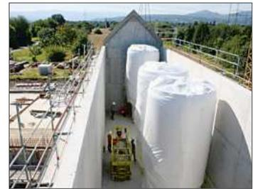
Die neuen Aktivkohlefilter zum Entfernen von PFC werden ins Wasserwerk Rauental eingesetzt. Jeder von ihnen hat einen Durchmesser von drei Meter und ist sieben Meter hoch
