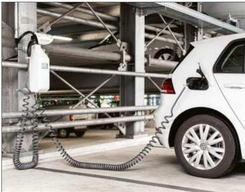
Die ChargeHere Ladelösung besteht aus schlanken TwinChargern, dem Bedienterminal ChargePanel und einem Schaltschrank, der ChargeBase
