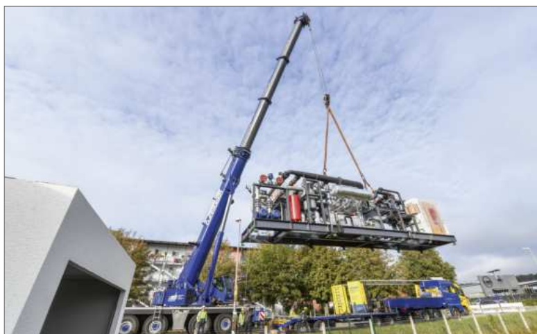
ORC-Anlieferung Energiezentrale Evonik
