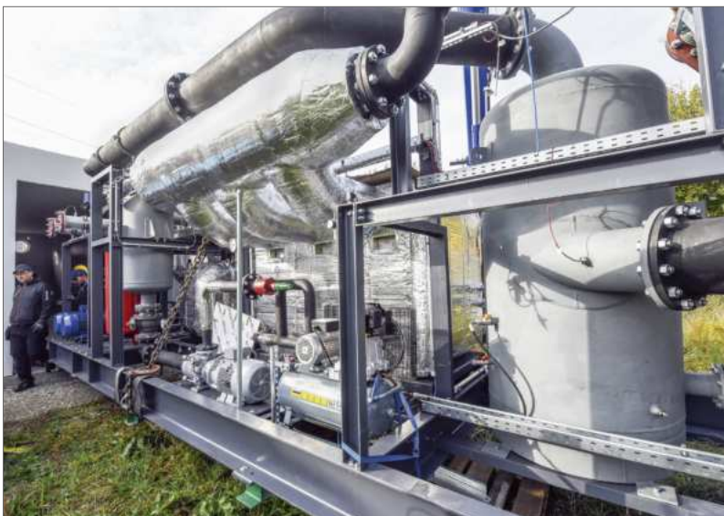
ORC-Einbau Energiezentrale Evonik
